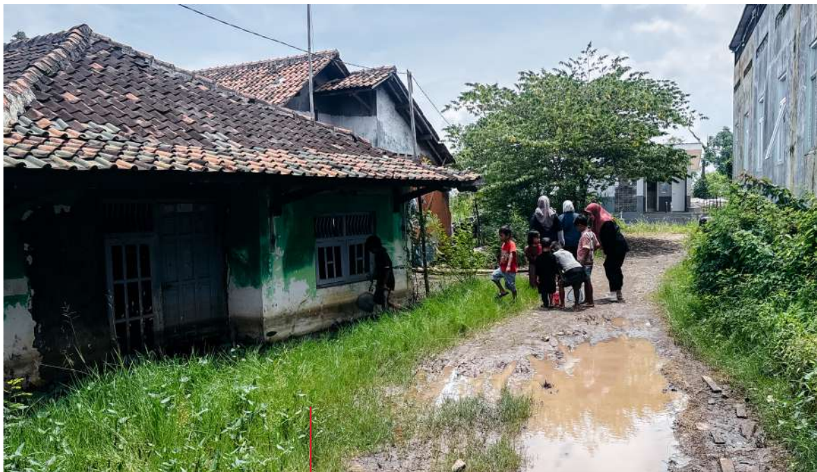
Rumah warga yang terdampak oleh peninggian tanah
